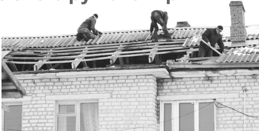
Ремонт крыши дома № 14 по ул. Гагарина
